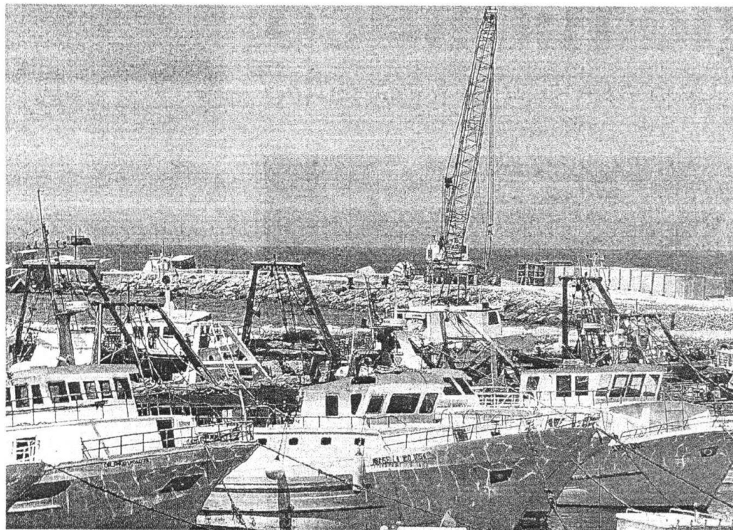
Il porto di Scoglitti è sottoposto ad una serie di lavori per migliorarne la funzionalità
